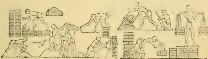
FIG. 1. — Fabrication de la brique.
